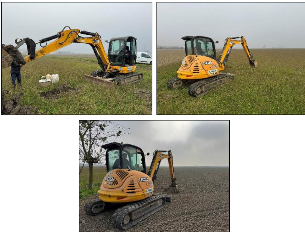
Figura 5.2: esecuzione delle trincee esplorative
