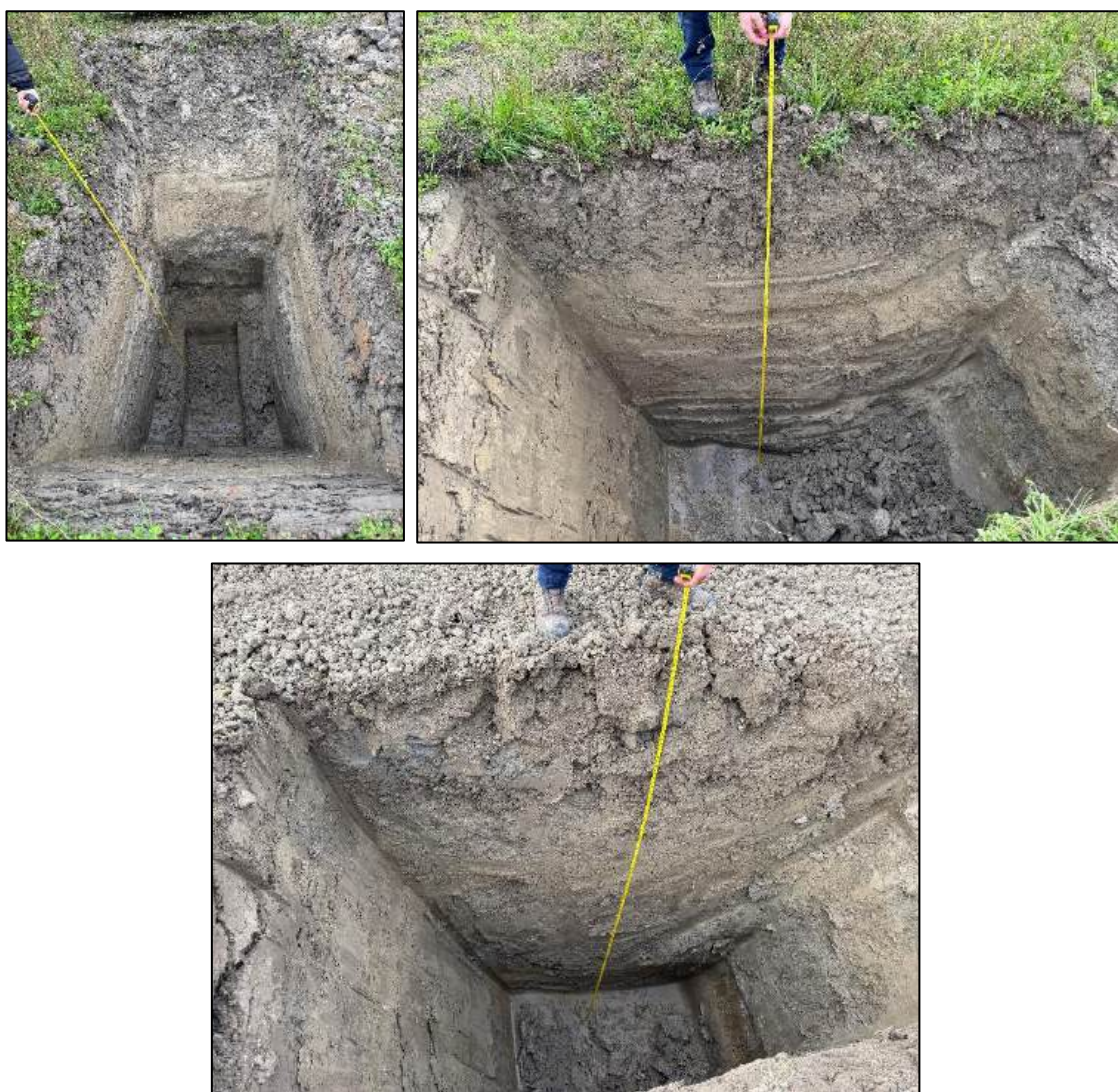
Figura 6.2.1: esecuzione delle trincee esplorative
